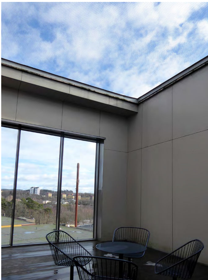
Balkong för utomhusvistelse barn- och ungdomspsykiatriska akutavdelningen vid Södra Älvsborgs sjukhus.
